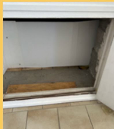
Marginea trapezi rigide (și, în cazul ușilor, lăsați spațiu pentru a o deschide, apoi ridicați trapa pentru a menține izolația) + fotografie
