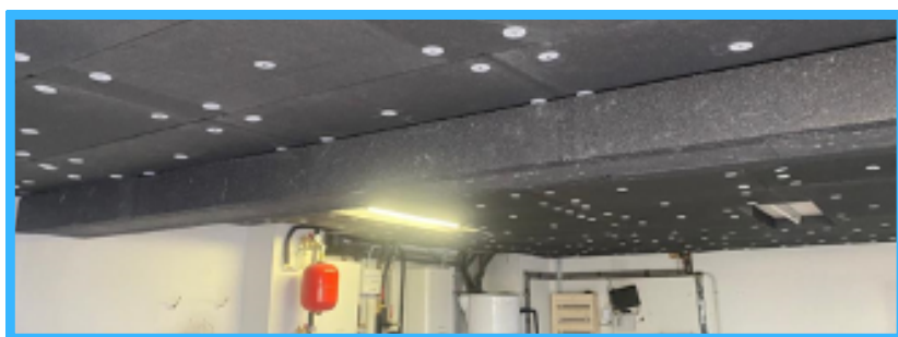
Grinzi izolate (cu excepția celor din lemn) + fotografii
