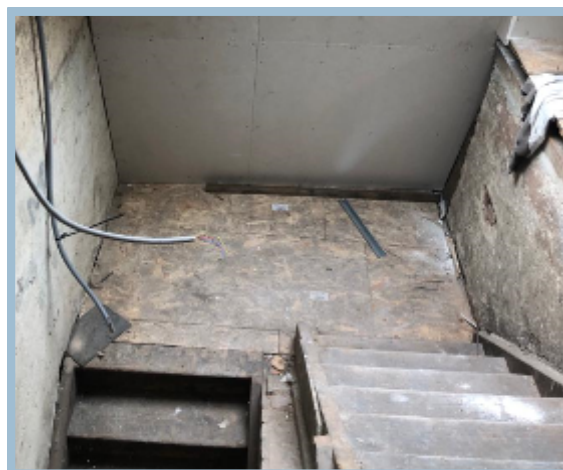
Photo de l'accès aux rampants (escalier ou porte)
