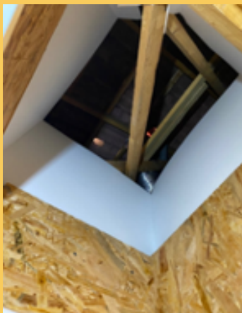
Контур жорсткої кришки (якщо це двері, залиште місце для її відкриття, а потім підніміть кришку, щоб утримувати ізоляцію) + фото
