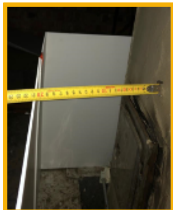
Distanța față de foc în jurul conduței de coș de fum (minim 15 cm) + fotografie
