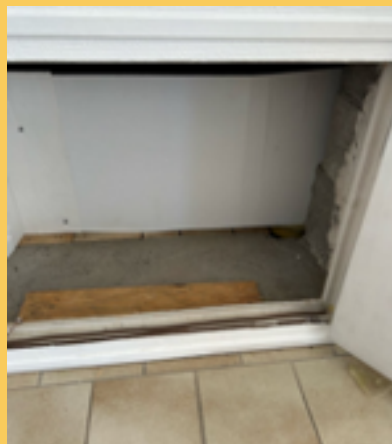
Contour de trappe rigide (si porte laisser la place pour l'ouvrir puis rehaussé trappe pour maintenir l'isolant) + photo
