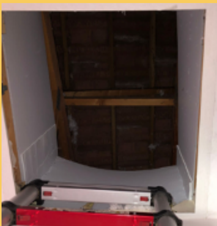
Contour de trappe rigide (si porte laisser la place pour l'ouvrir puis rehaussé trappe pour maintenir l'isolant) + photo
