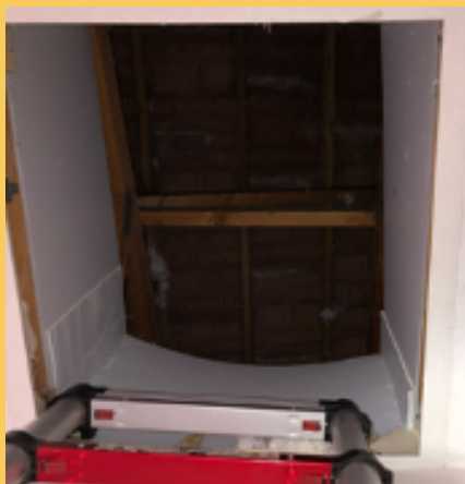
Marginea trapezi rigide (și, în cazul ușilor, lăsați spațiu pentru a o deschide, apoi ridicați trapa pentru a menține izolația) + fotografie
