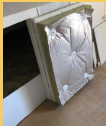
Теплоізоляція люка + фото
