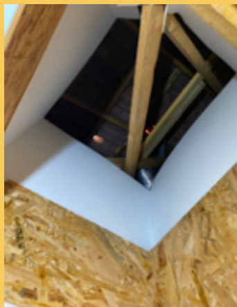
Marginea trapezi rigide (și, în cazul ușilor, lăsați spațiu pentru a o deschide, apoi ridicați trapa pentru a menține izolația) + fotografie
