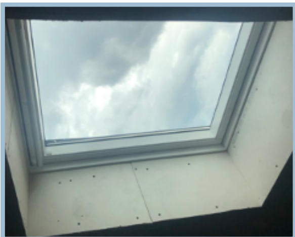
Encadrements des fenêtres + photos
