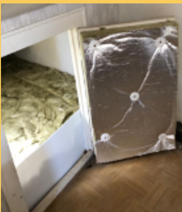
Теплоізоляція люка + фото
