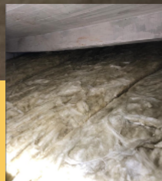
Теплоізоляція повинна бути розподілена рівномірно (без гірки)
