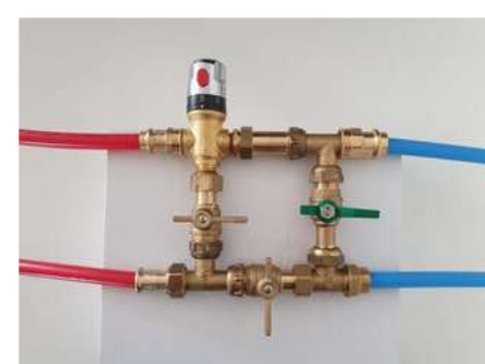
Position fermeture total de l'eau chaude
