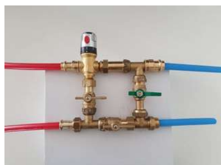
Position des vannes en hiver
